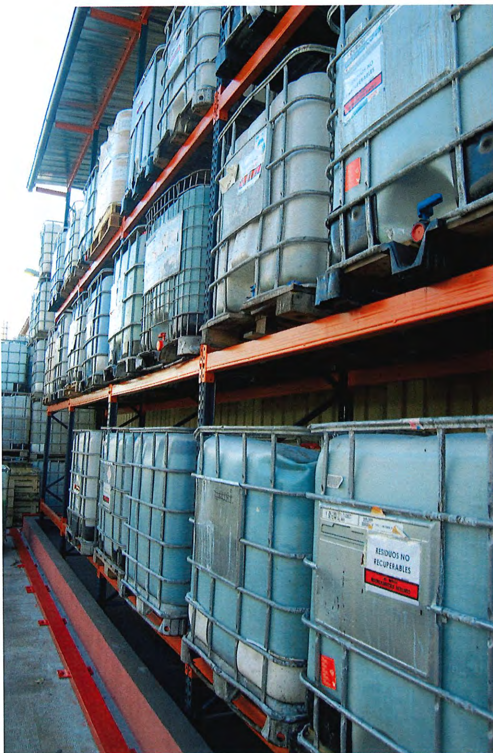
6 - VISTA GENERAL DE LA ZONA ESPECIAL MAGATZEM PER ELS RESIDUS LIQUIDS
