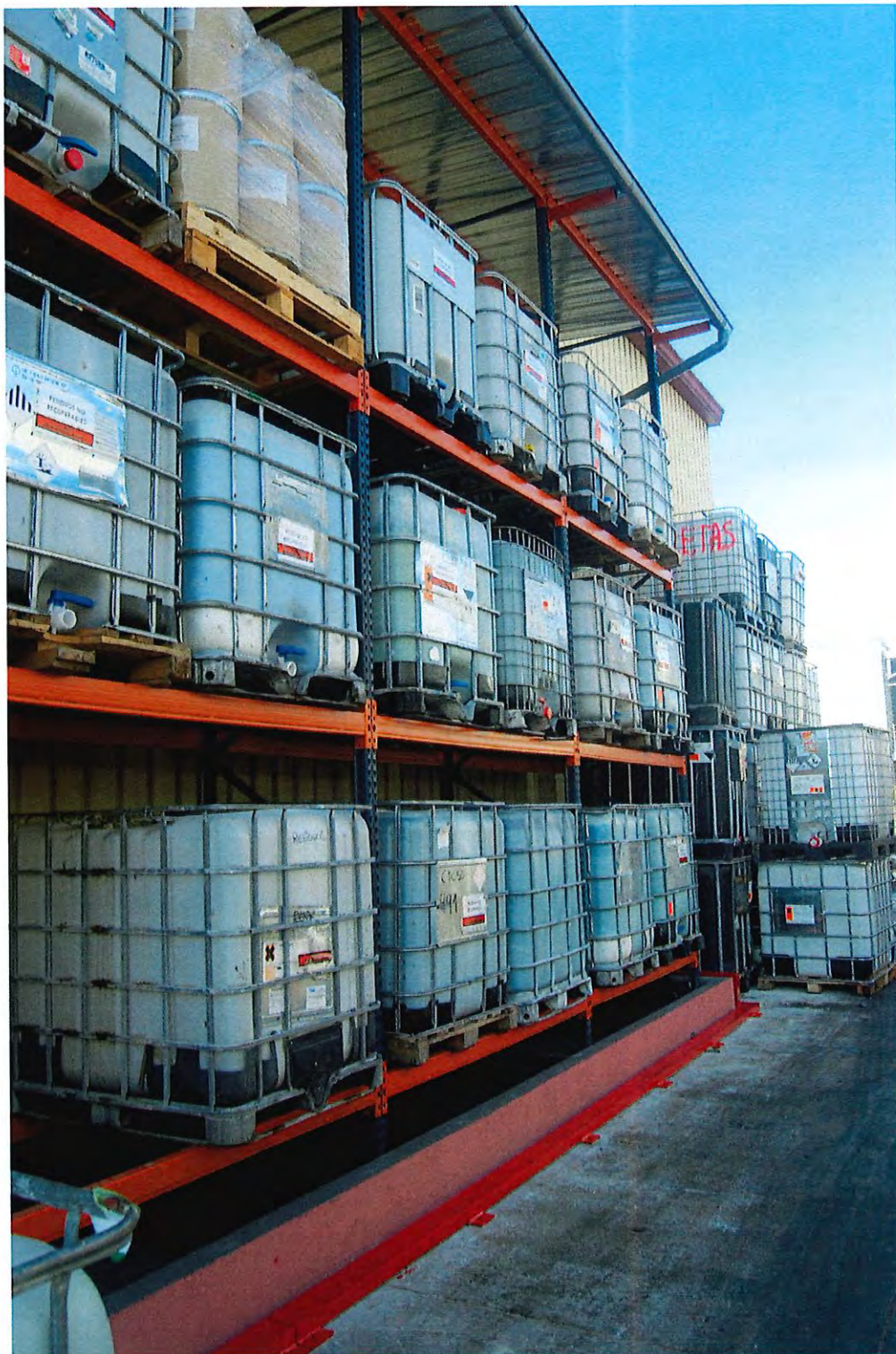
5 - VISTA GENERAL DE LA ZONA ESPECIAL MAGATZEM PER ELS RESIDUS LIQUIDS
