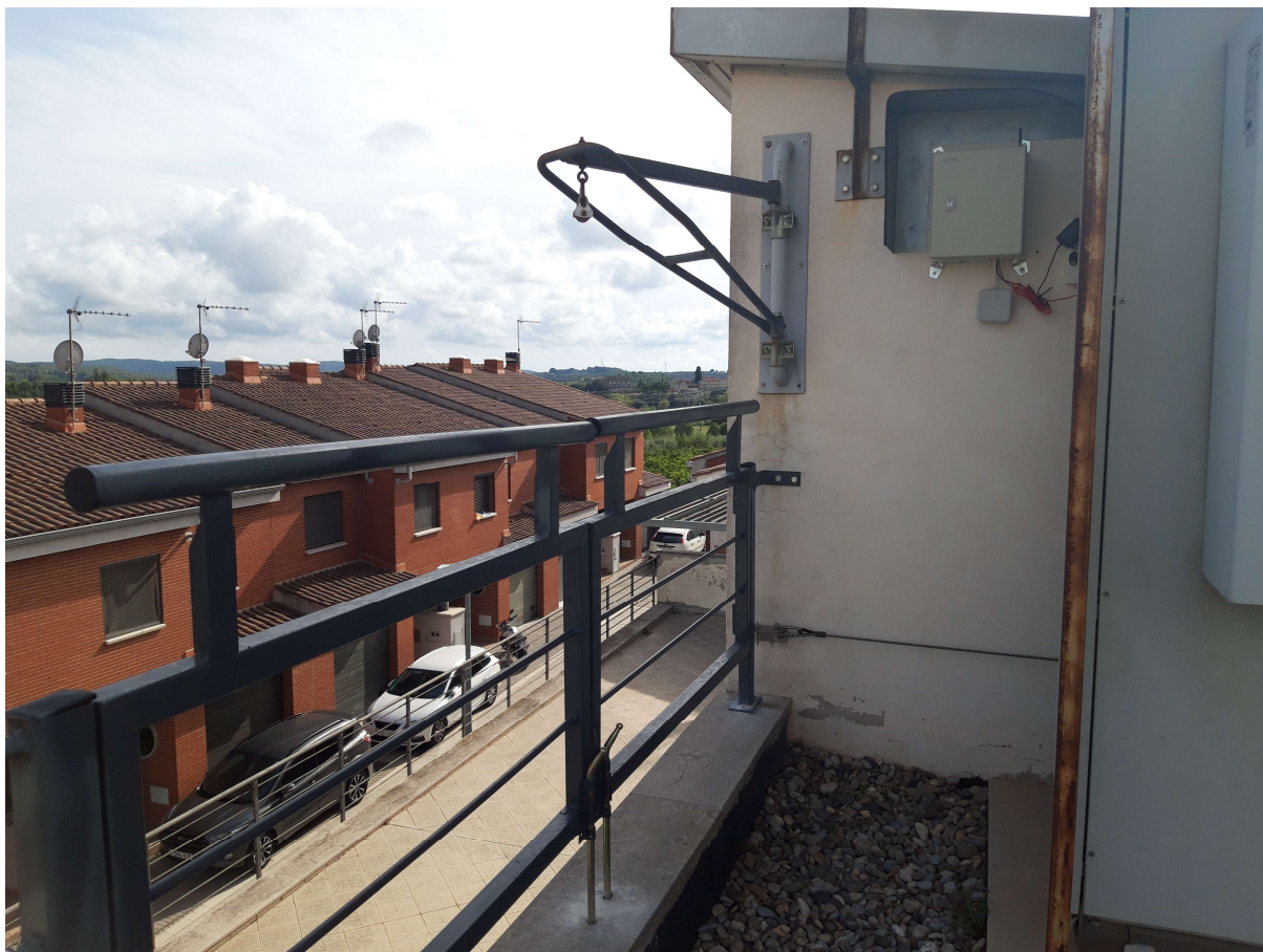
Figura 2. Equip instal·lat a Antistiana.
